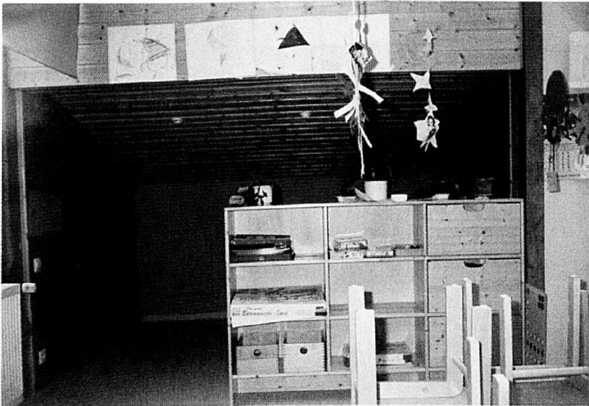
Abb. 12: Die Höhe dieser in den Gruppenraum einbezogenen Nische ist durch Herabsetzung der Decke an den kindlichen Maßstab angepaßt worden. (St. Josef Kindergarten, Kaltenengers; Fotos: Inka Schmitz).
